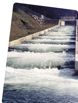
Passe à échancures triangulaires sur la rivière La Neste, Midi-Pyrénées, France, © F. Travade
